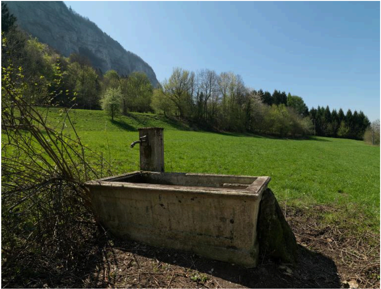
Vue d'ensemble du bassin en béton.
