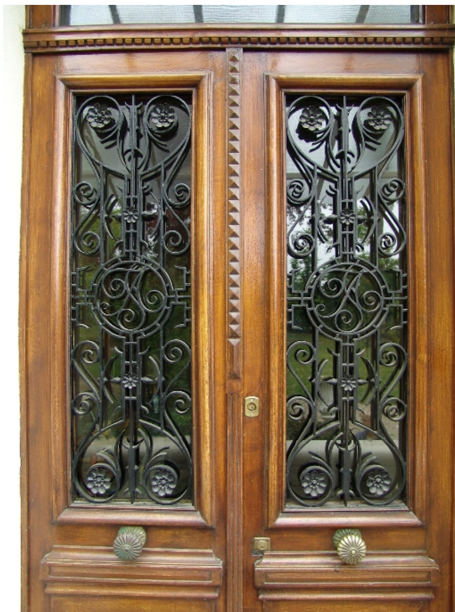
Grille de la porte d'entrée
