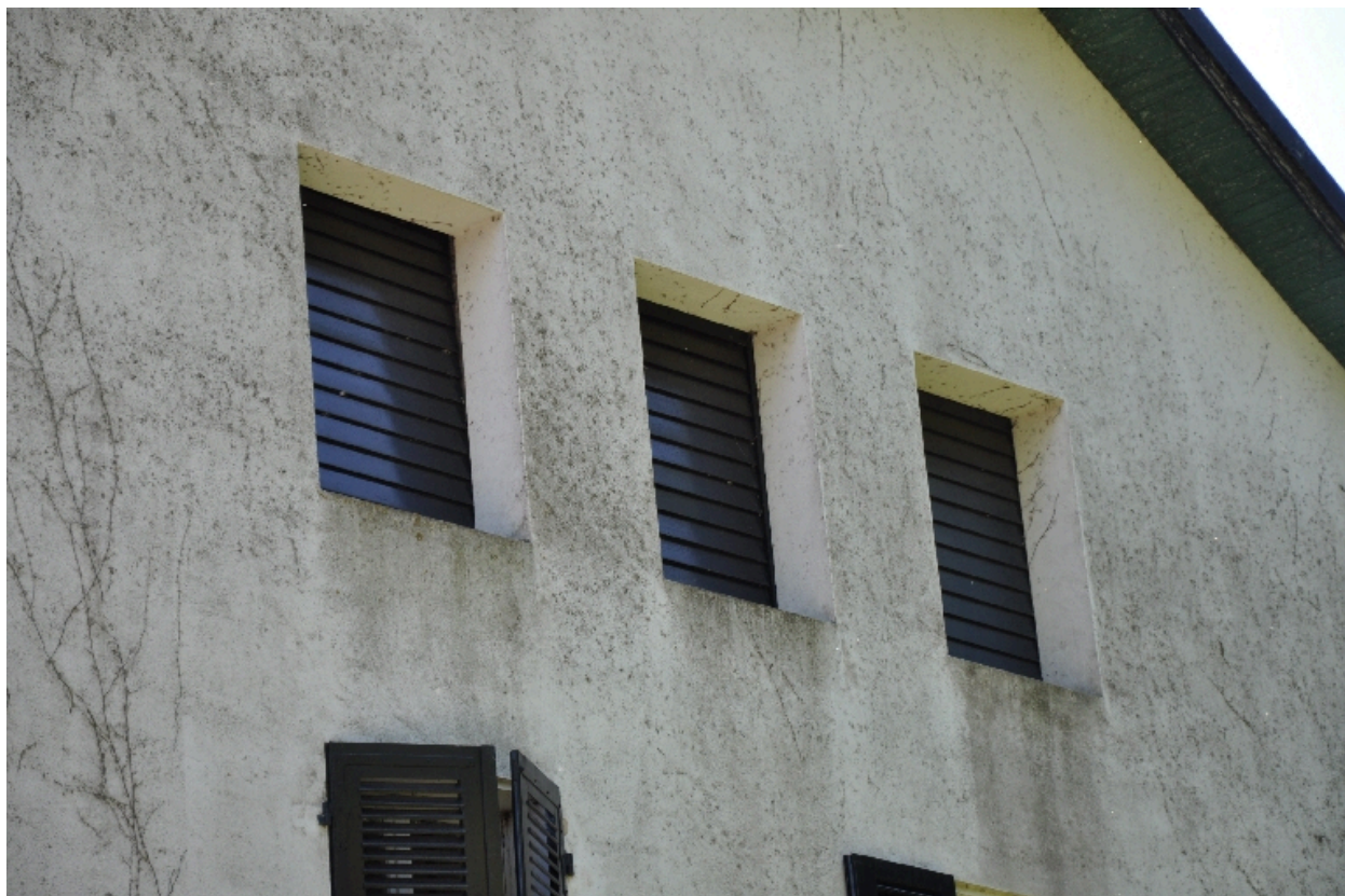
Détail des ouvertures du séchoir au troisième niveau
