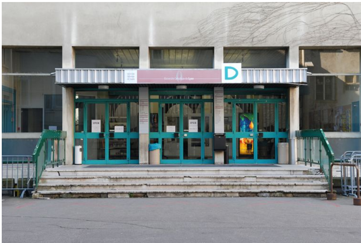
Bâtiment ISARA, élévation antérieur, détail du perron
