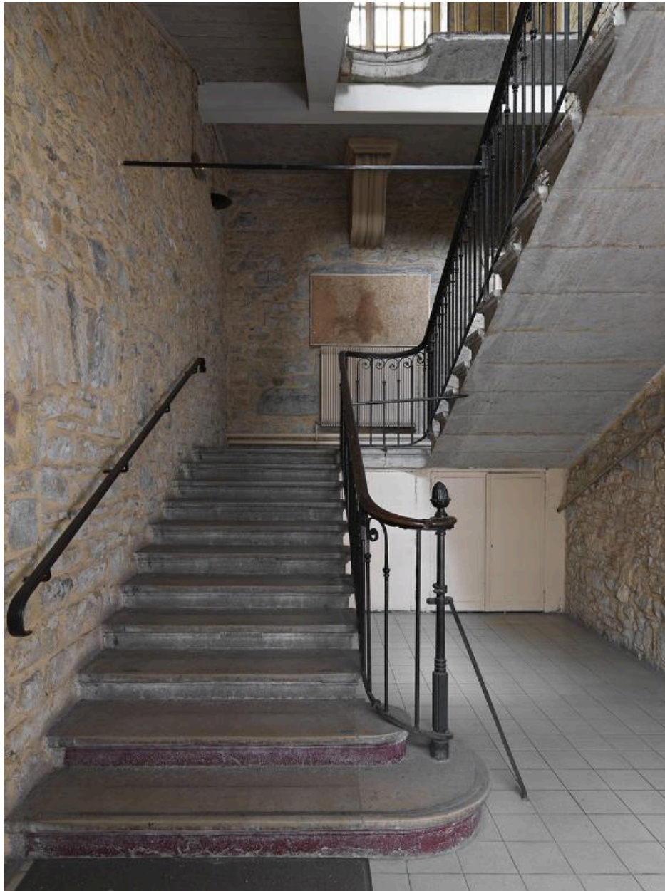
Cour d'honneur, corps de bâtiment nord : escalier B, 1ère volée
