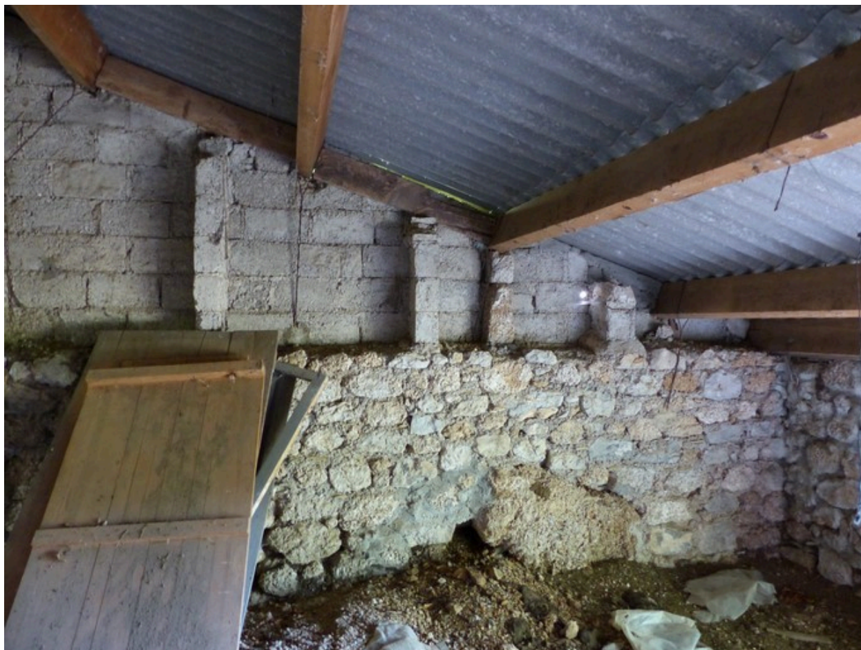
Etage de soubassement, remise. Mur est.
