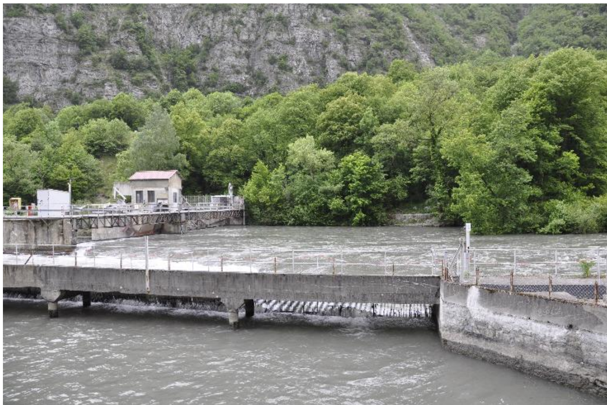
Vue du barrage et de ses installations
