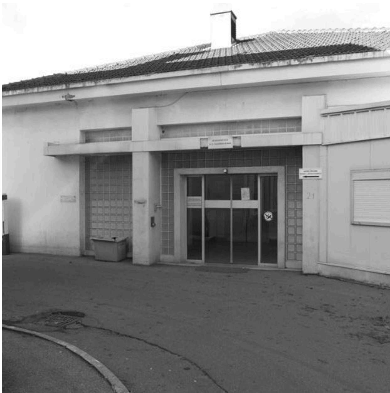
Bâtiment W, entrée principale au sud
