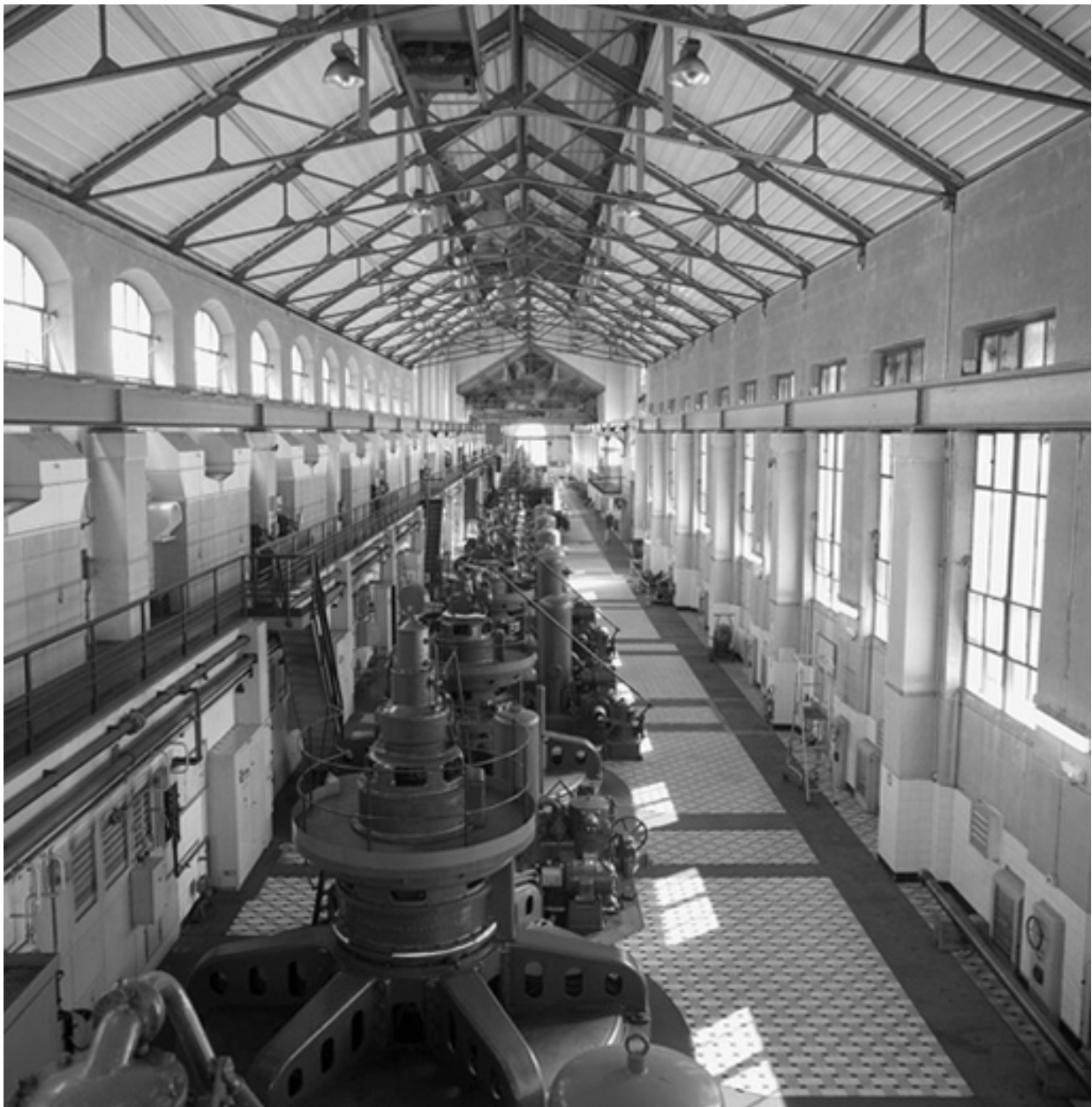
Vue d'ensemble salle des machines
