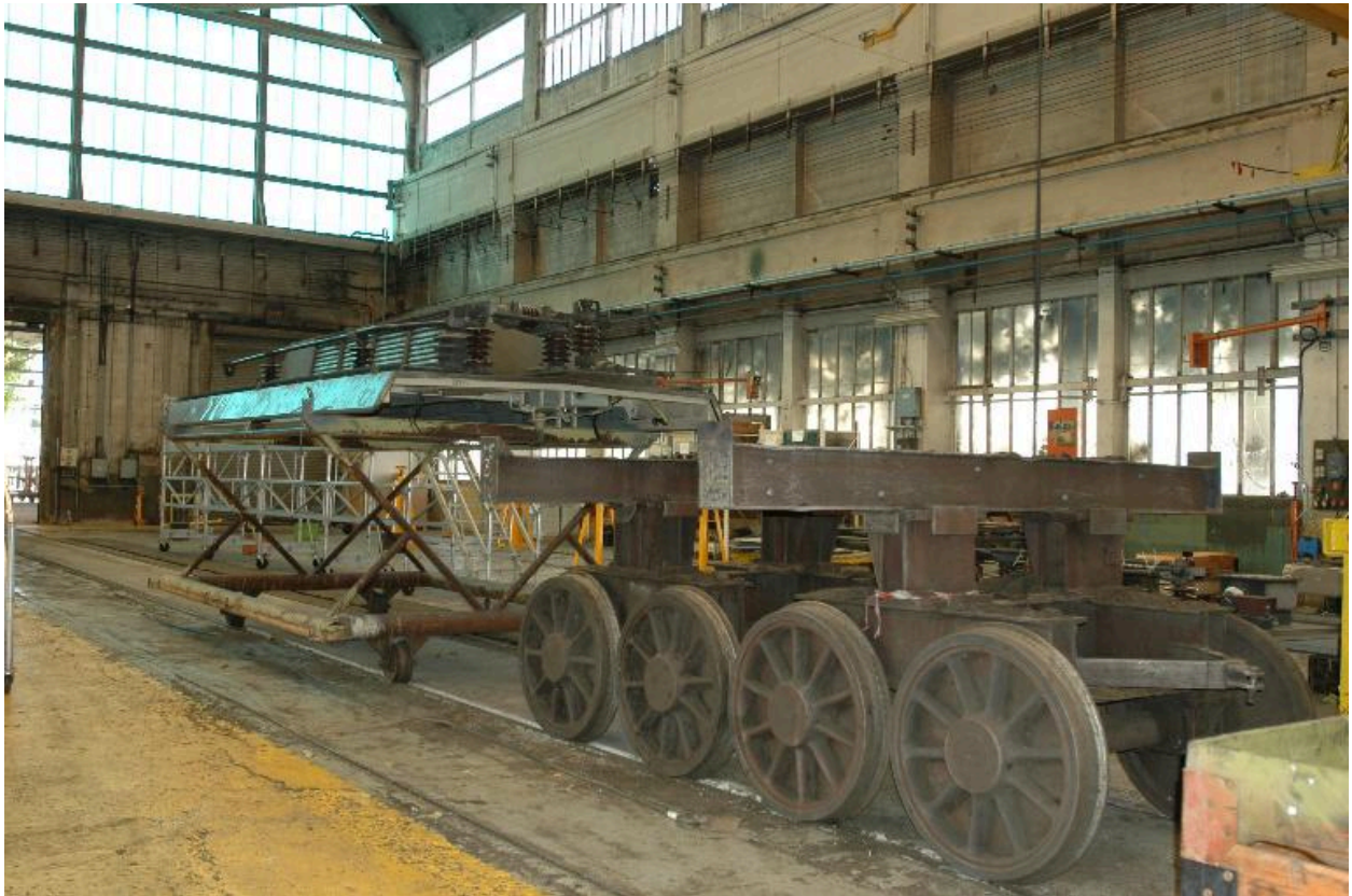
Vue intérieure atelier de réparation
