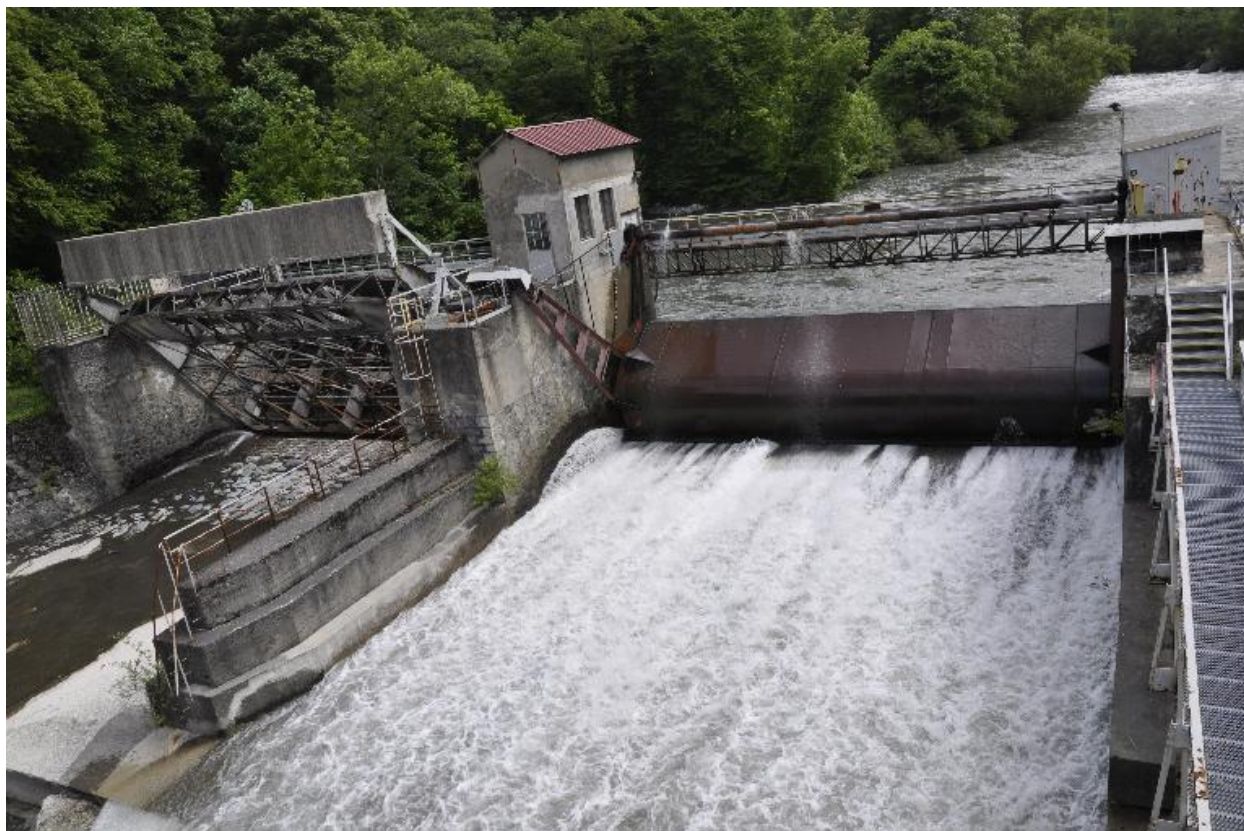
Vue aérienne du barrage
