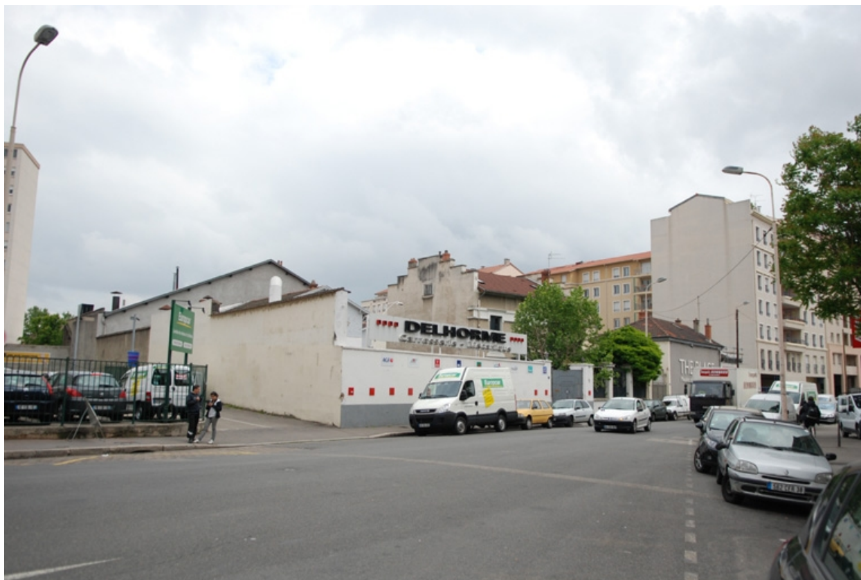
Vue extérieure d'ensemble
