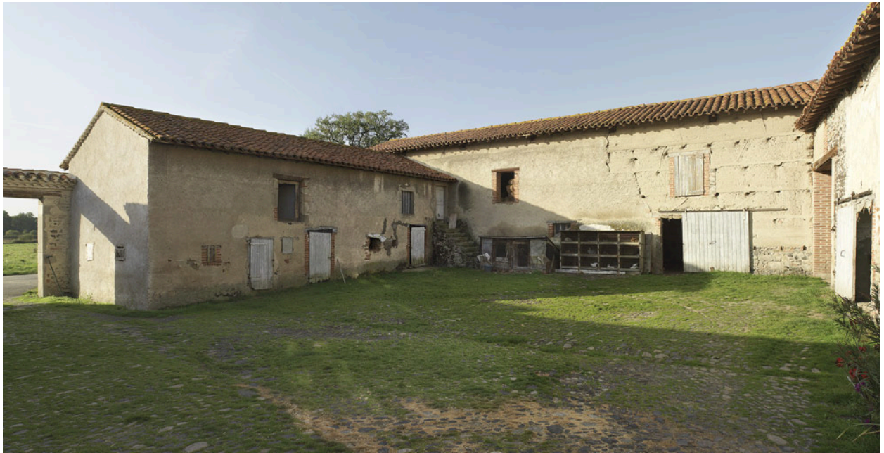
Vue intérieure de la cour depuis le nord : grange-étable, écurie, cave, porcherie et grenier-fenil.
