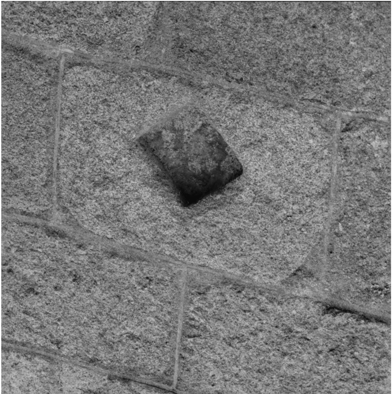
Détail d'une pierre creusée sur la façade occidentale.
