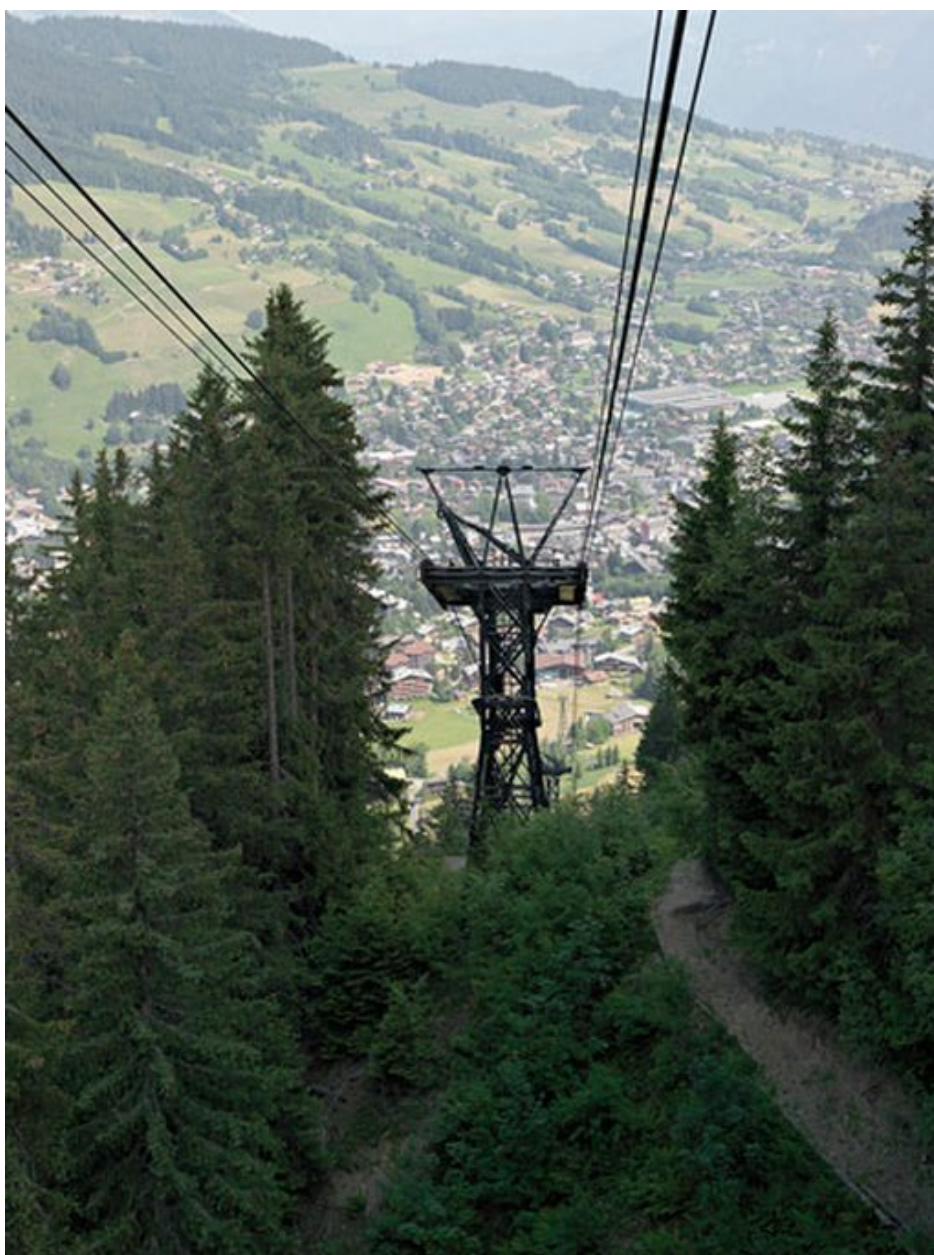
Le pylône supérieur depuis l'amont
