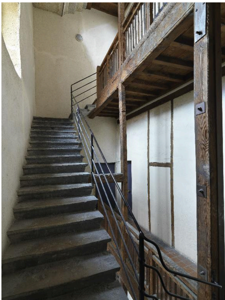
Vue d'une volée, de la main courante en ferronnerie et des poutres de l'escalier secondaire du n°4 rue Dumenge
