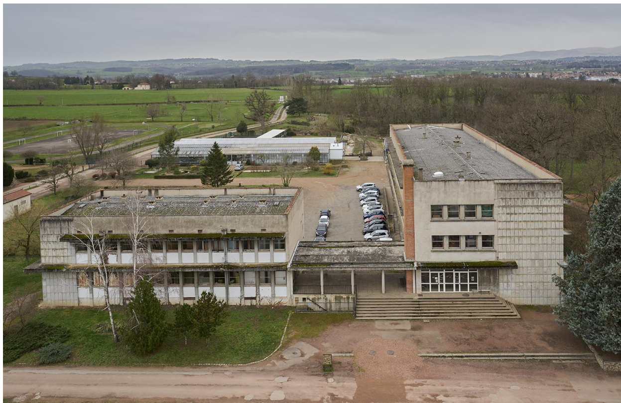
Bâtiments B et C : vue aérienne depuis le nord-est
