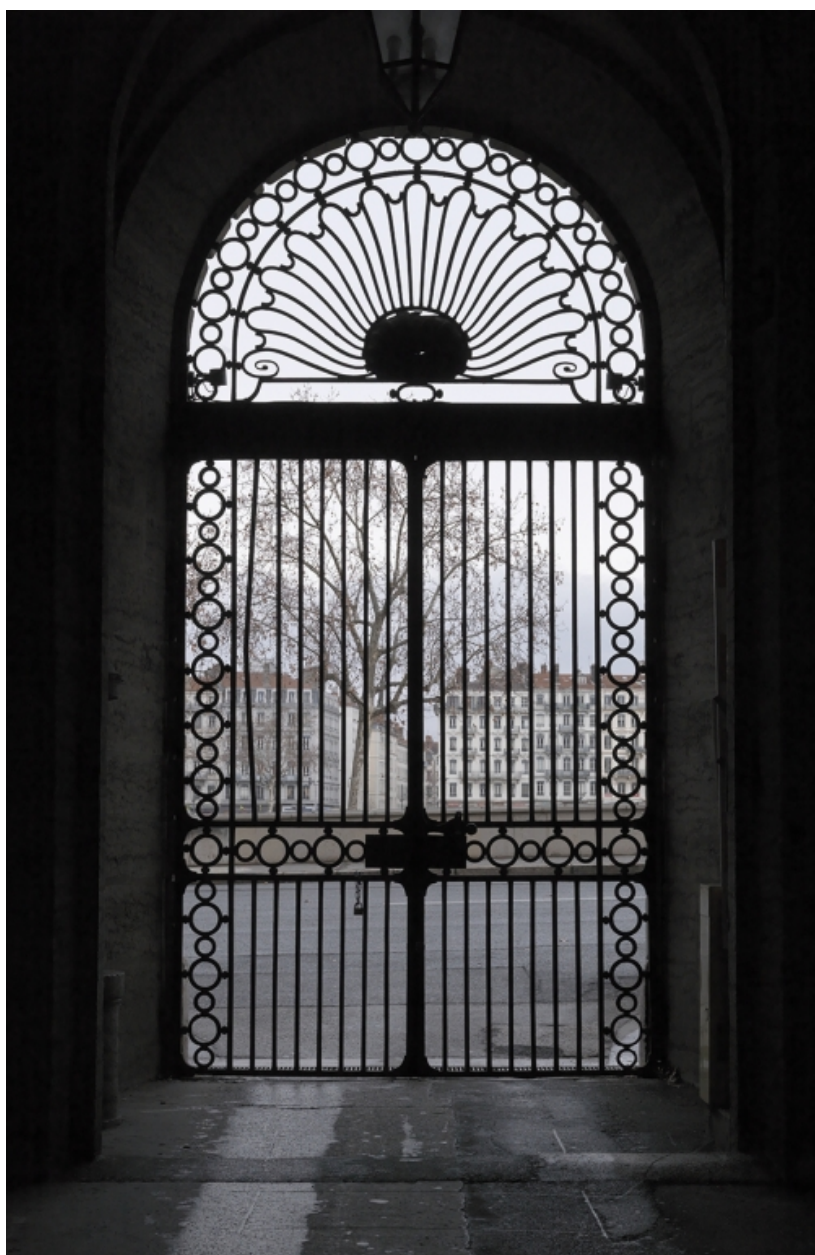
Vue générale depuis la cour
