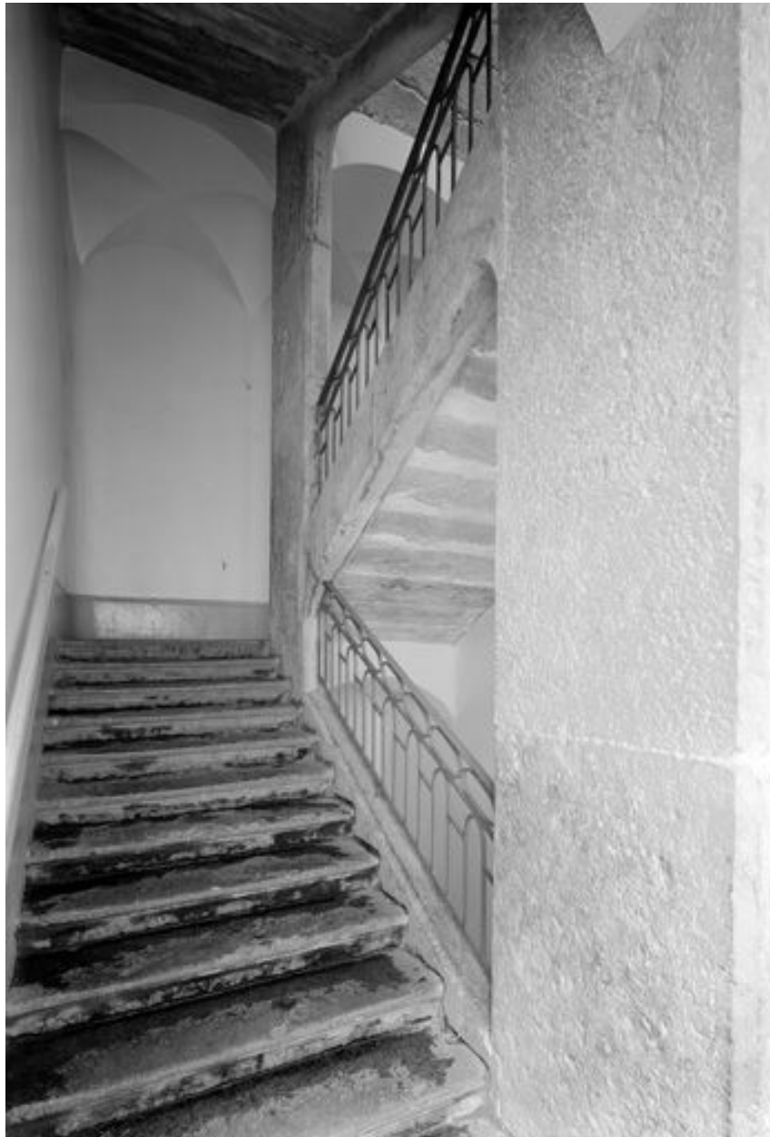
1ère cour, escalier ouest, vue d'un étage d'escalier
