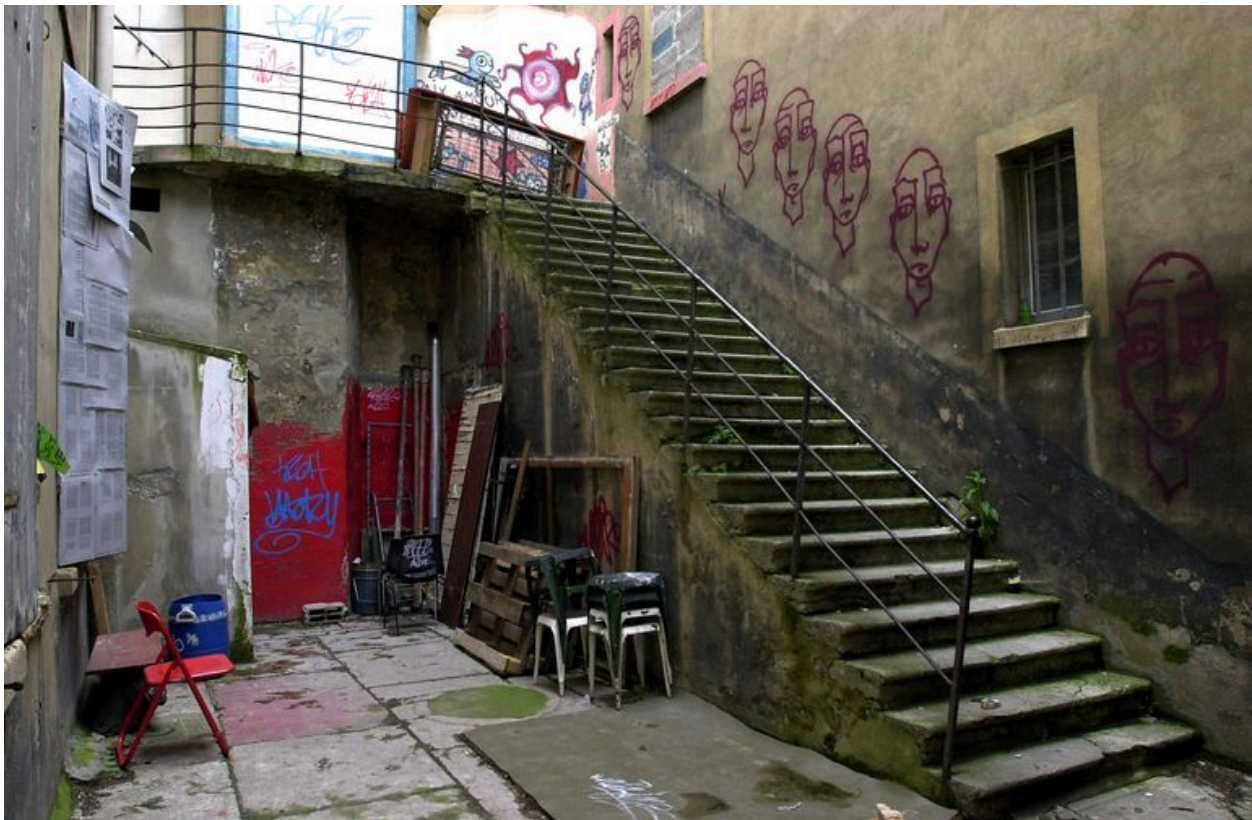
Corps n° 14, escalier dans la cour
