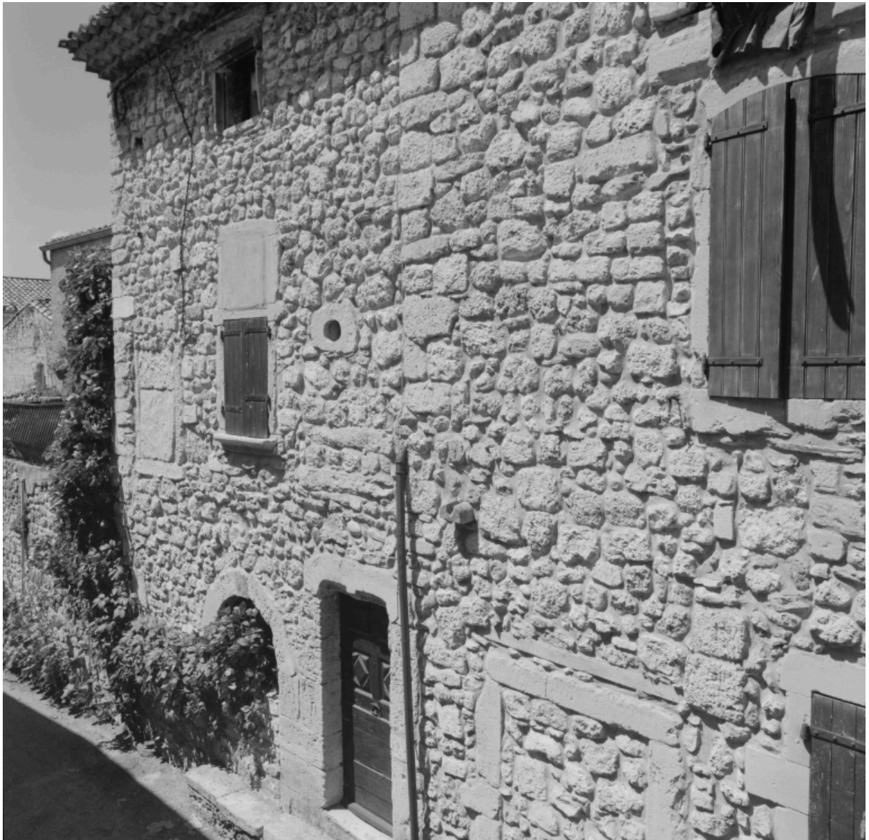
Maison (A 596), Grande rue, vue générale de la façade.
