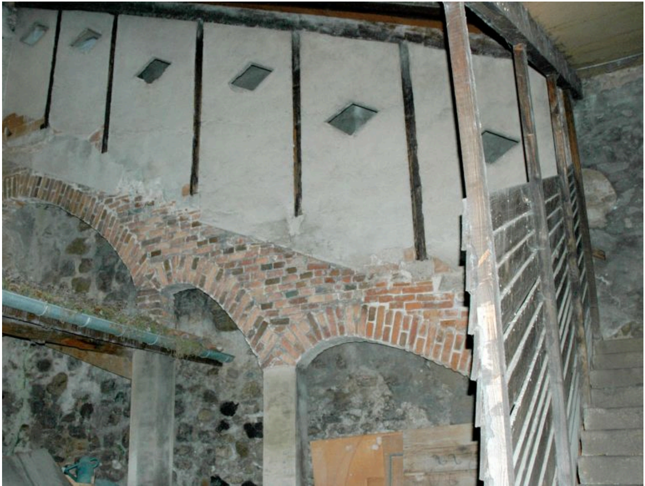
Escalier donnant accès à la rue Claude Henry, depuis le jardin en terrasse.
