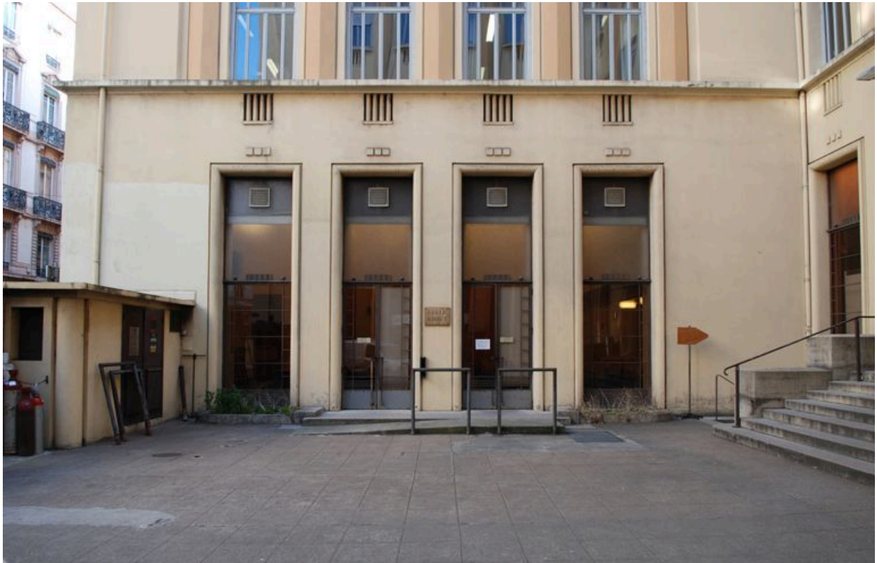
Cour d'honneur, élévation latérale nord, détail du rez-de-chaussée
