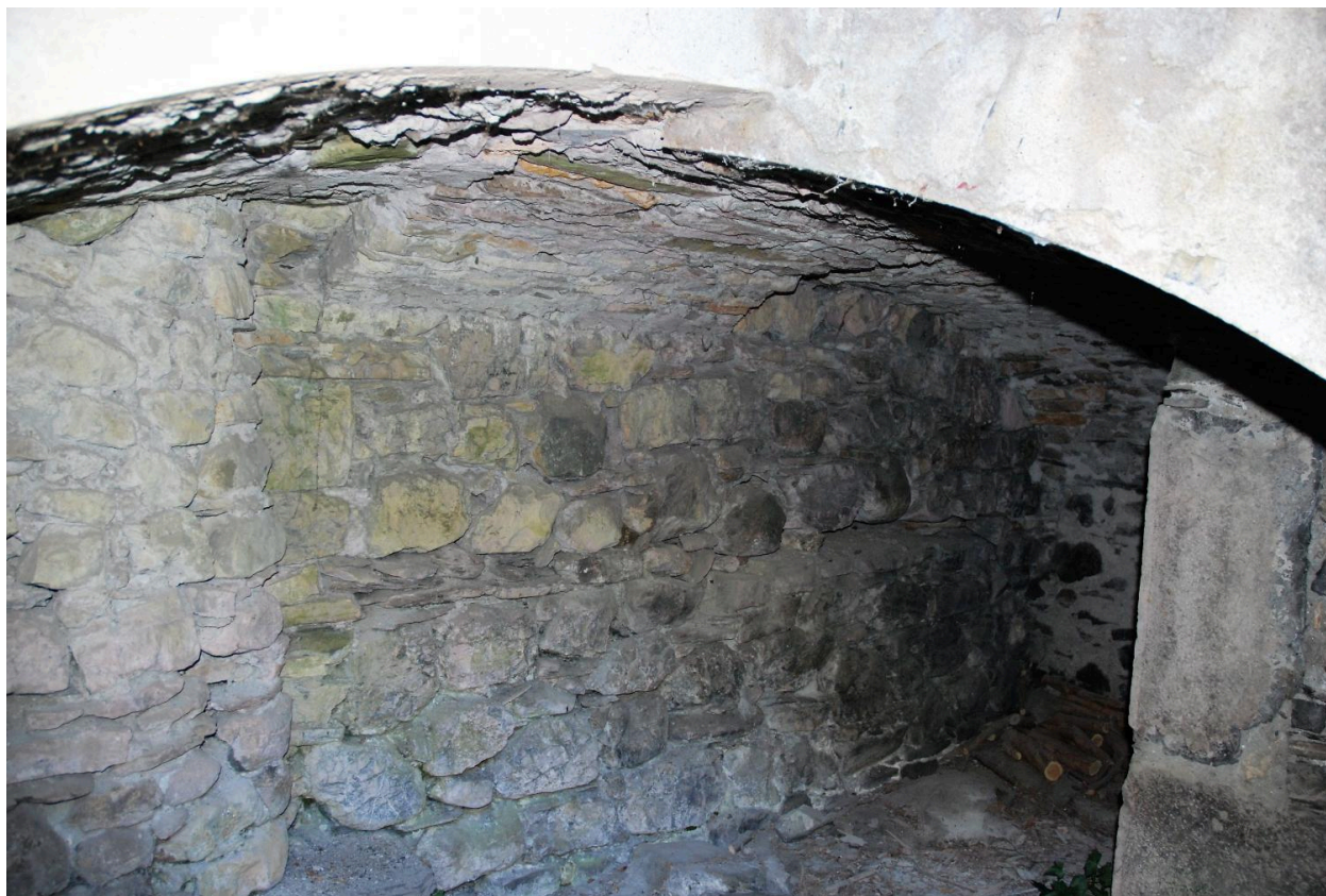
Maison, immeuble, 100 rue Louis Blanc-Pinget (2018 E1 1797). Vue intérieure d'une cave.
