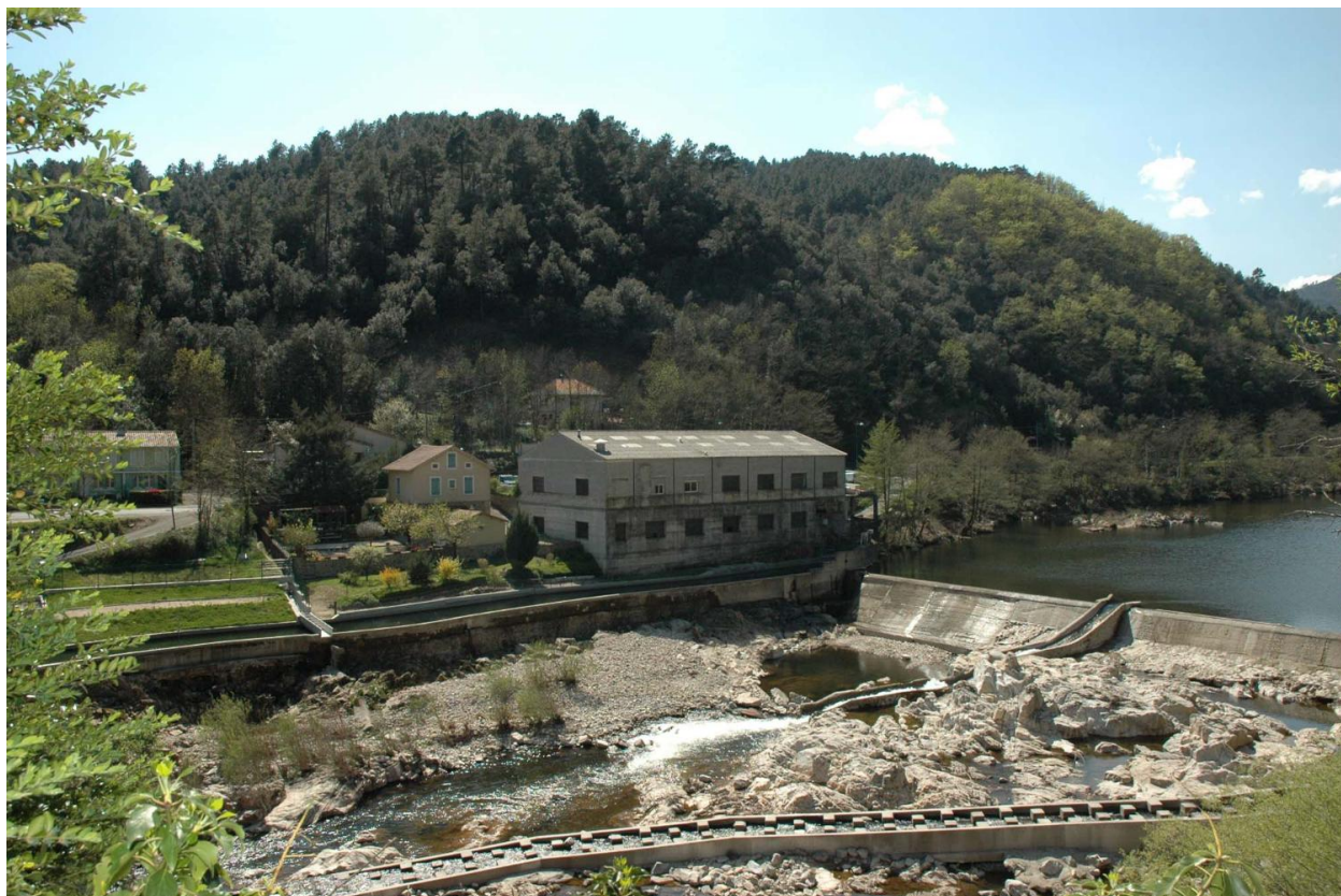
Aménagement hydraulique et canal
