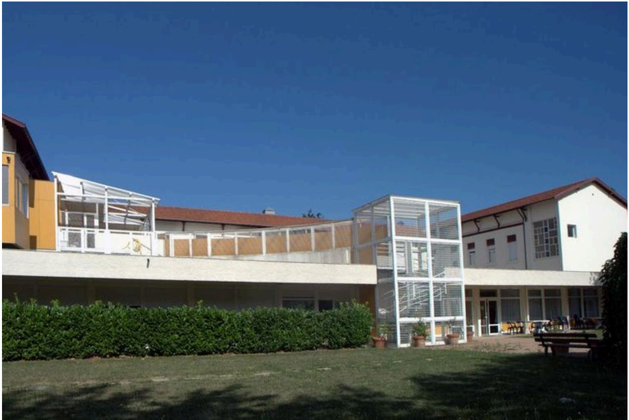
Façade postérieure (est) avec l'adjonction moderne
