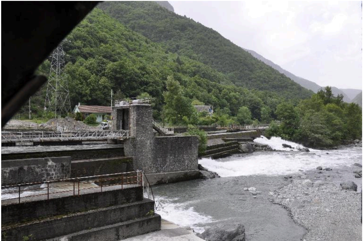
Vue des installations du barrage de Pierre-Eybesse et de la Romanche
