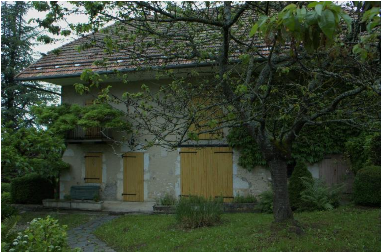
Vue partielle de la façade principale.
