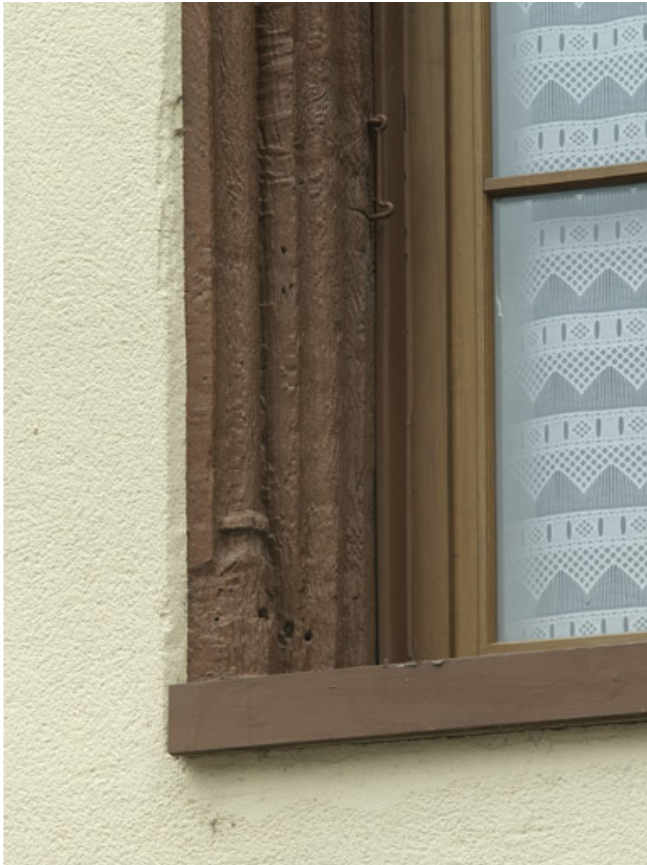
Détail d'un piédroit sur base prismatique en bois, 5 rue Saint-Pierre.
