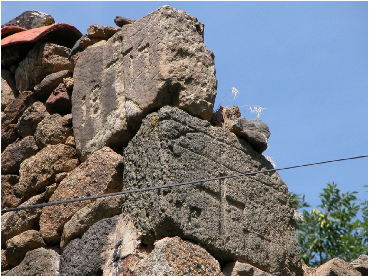
Détail des moellons d'angle datés (1986 AL 220).
