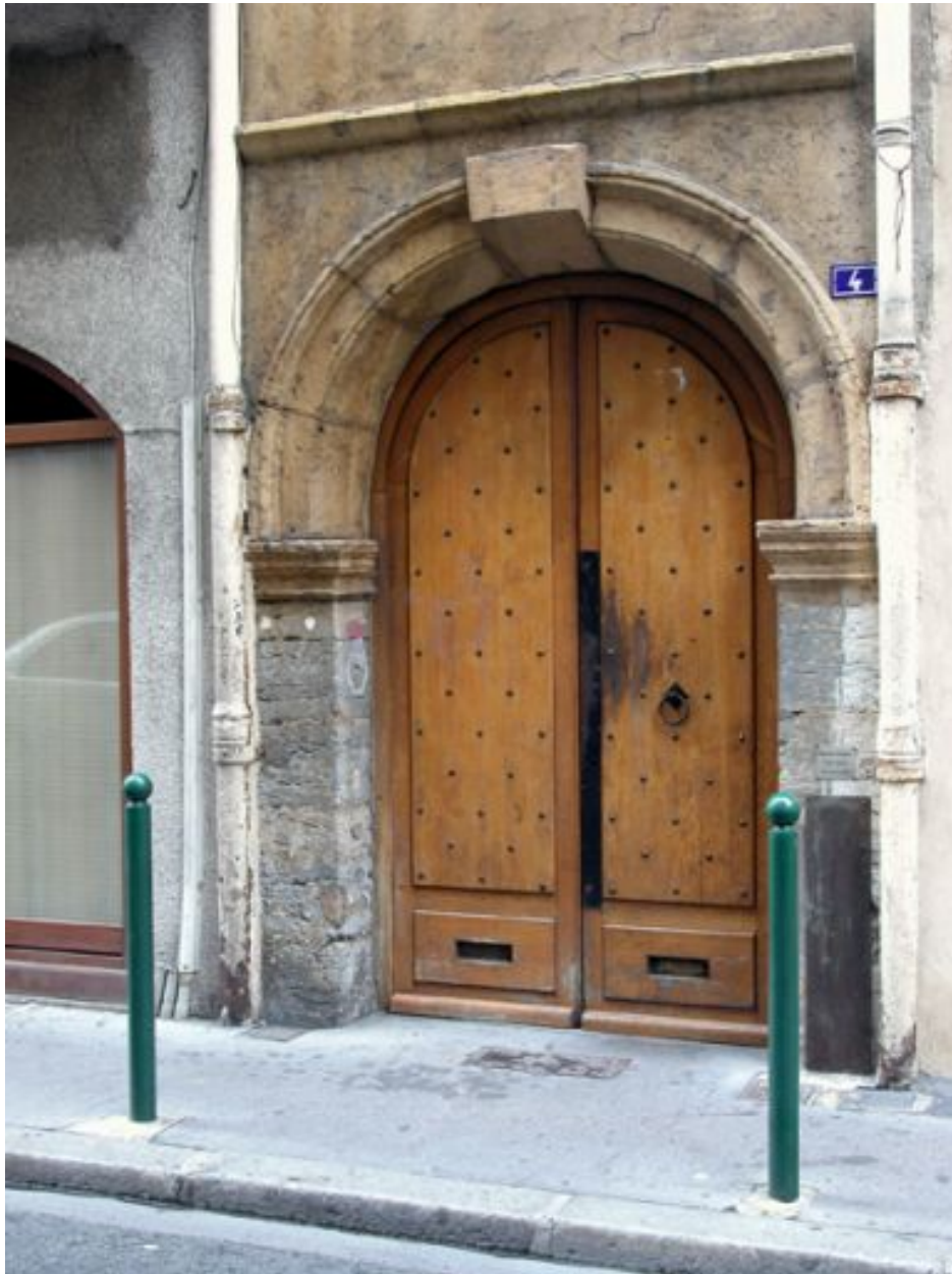
Façade principale rue Dubois, porte
