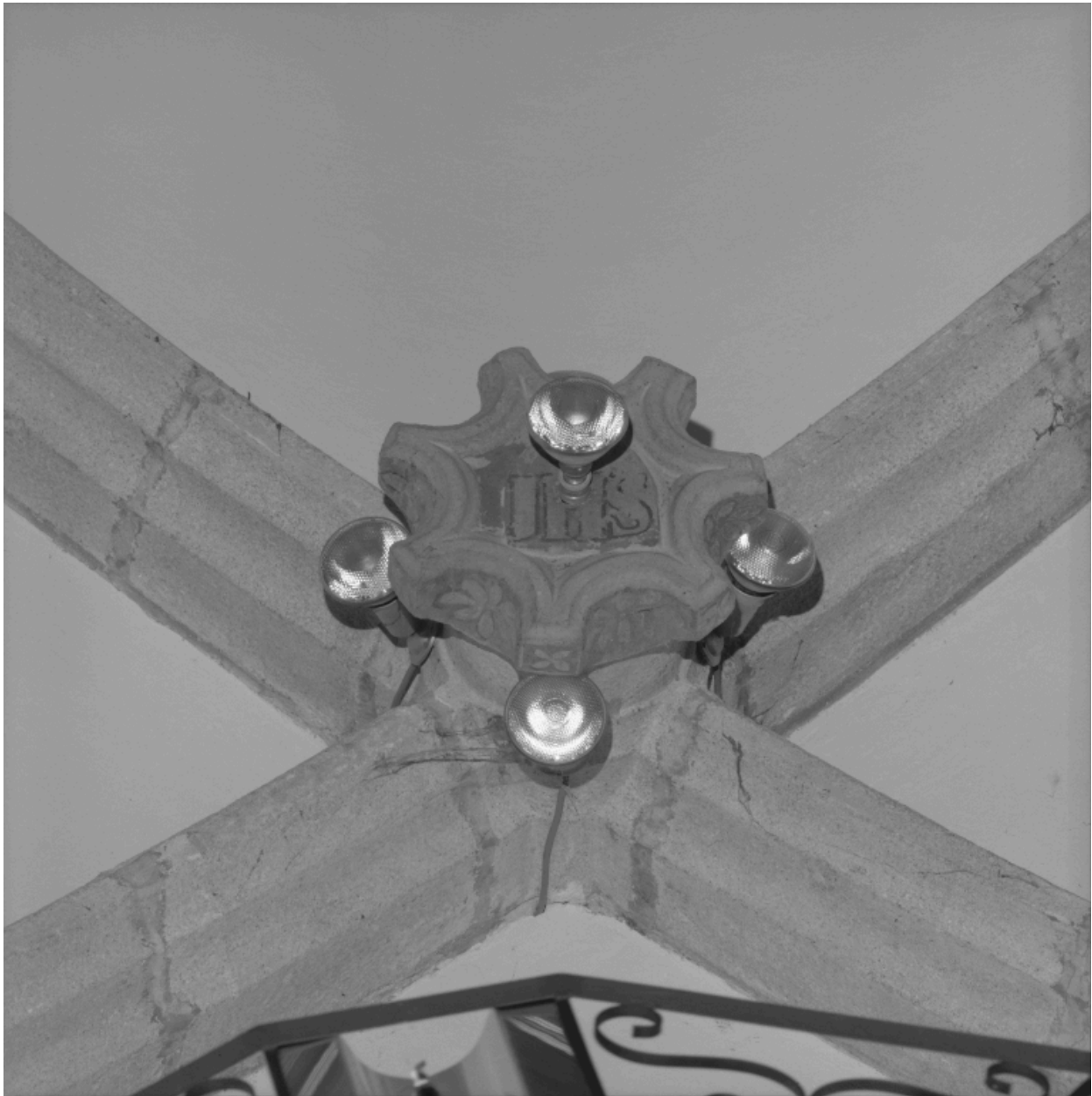
Détail de la clef de voûte de la deuxième travée de la nef.
