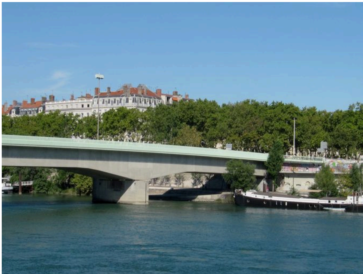
Vue partielle, travée gauche, face aval (depuis la rive droite)
