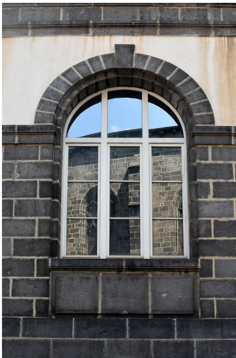
Elévation postérieure, détail d'une baie de l'extension du 20e siècle
