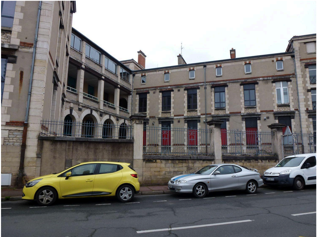
Vue depuis l'avenue Jules-Ferry sur une des cours de service.
