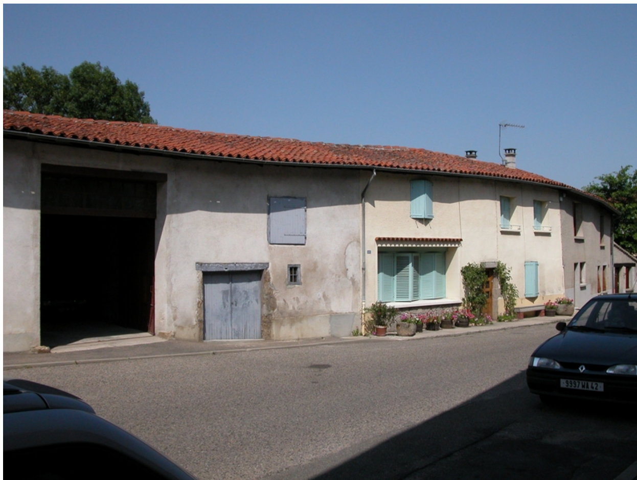
Faubourg de la Sablière. Ferme, café, atelier du sabotier Doitrand (1999 AB 58 à 63, place de la Barrière).
