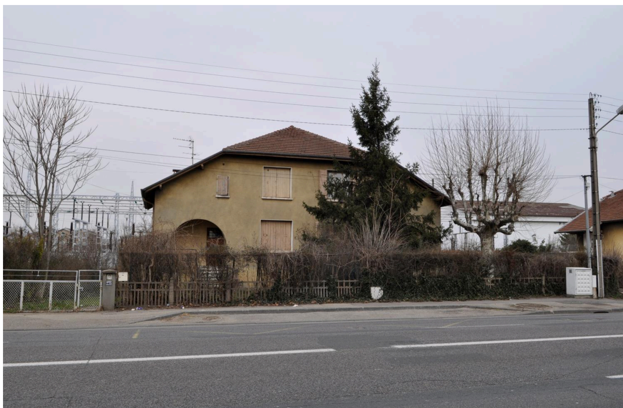
Vue d'extérieur, logements ouvriers, cité EDF
