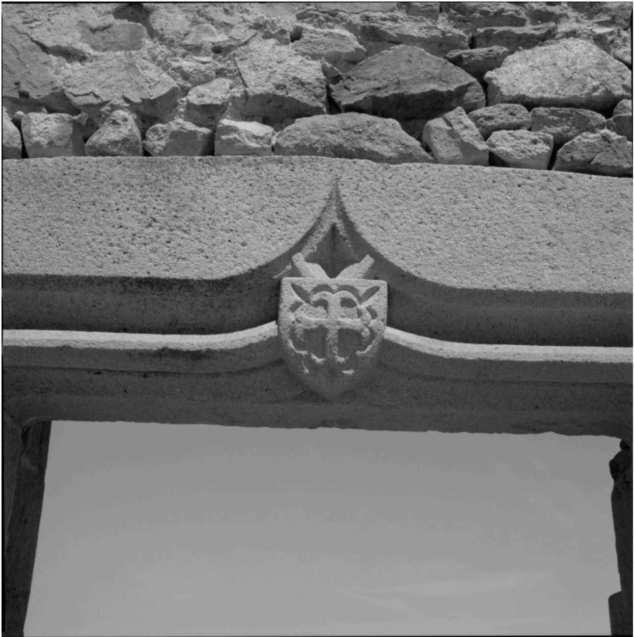
Premier baile, partie nord de la première enceinte, logis dit logis du Capitaine : détail du linteau en accolade de la porte d'entrée portant les armoiries de la famille de Damas, du sud-est.
