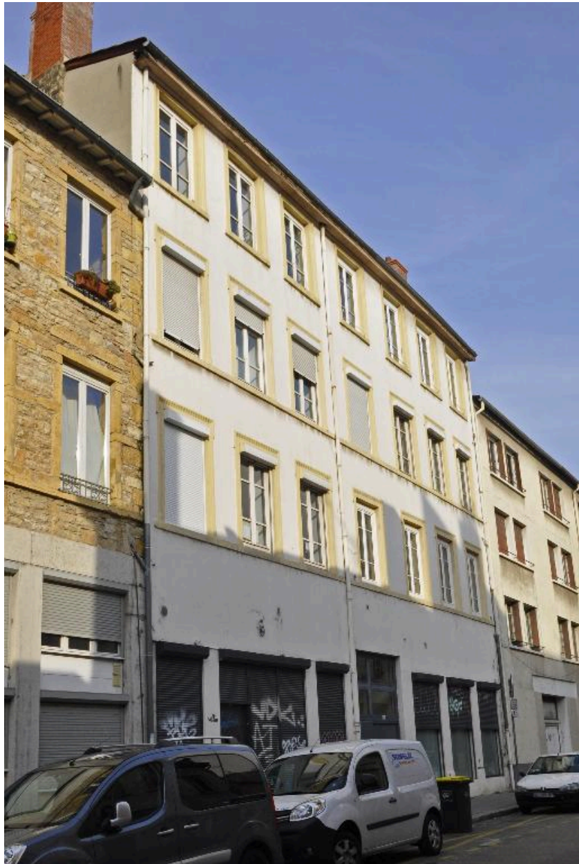
Elévation sur rue, vue générale
