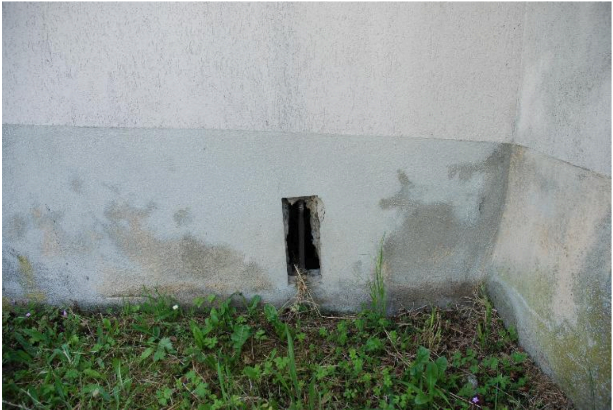
Sopirail de la cave 2, située sous la tour sud-est du château.
