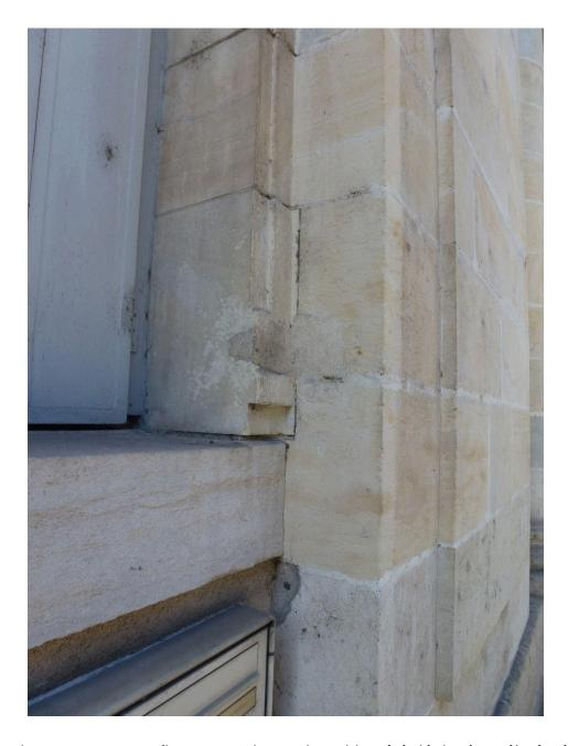
Détail de mise en oeuvre confirmant que le porche a bien été déplacé et réintégré dans la façade.
