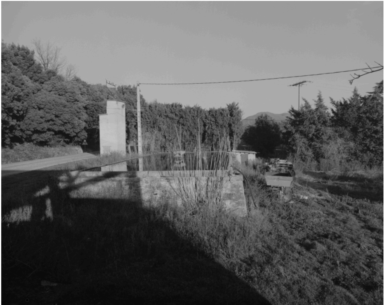
Les Plans : un des nombreux bassins de retenue de Montbrison-sur-Lez.
