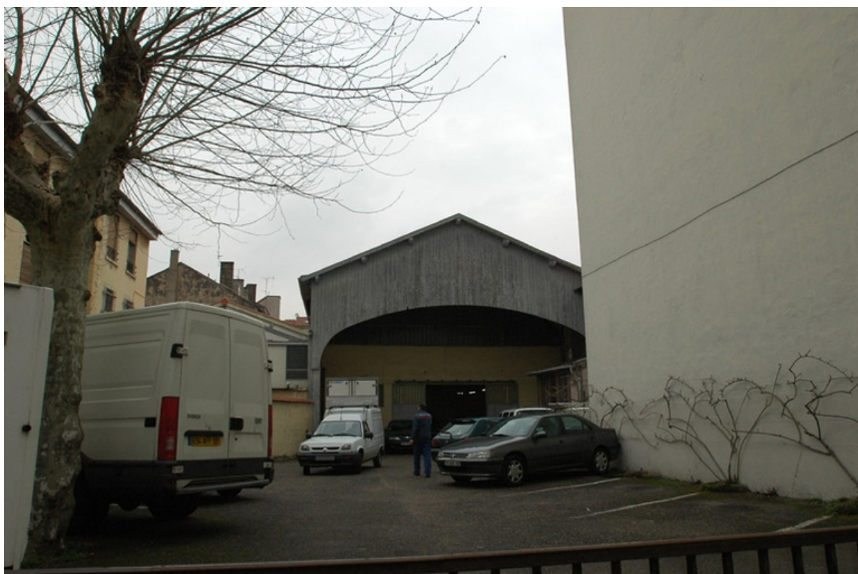
Façade principale du hangar rue Paul Bert, vue sud.
