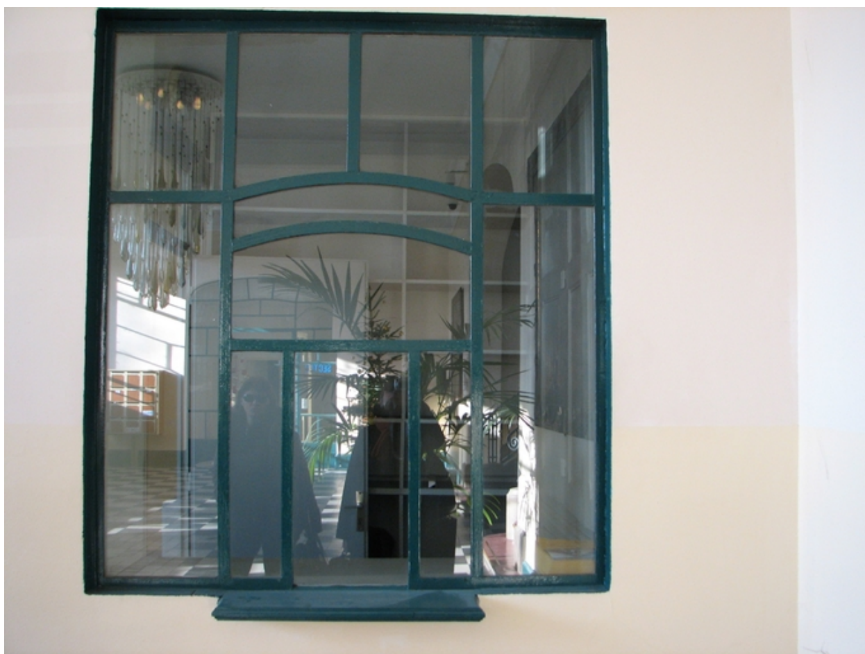
Baie des grands bureaux
