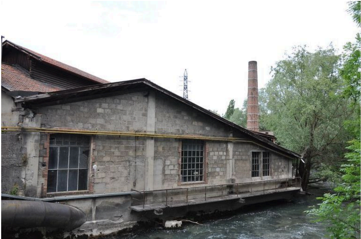
Bâtiment de l'usine en bordure du Thiou
