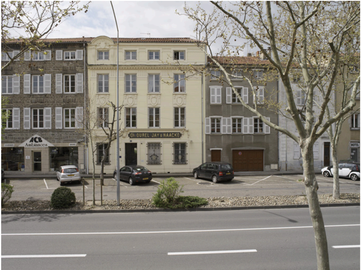
Vue de situation sur le boulevard Lachèze.
