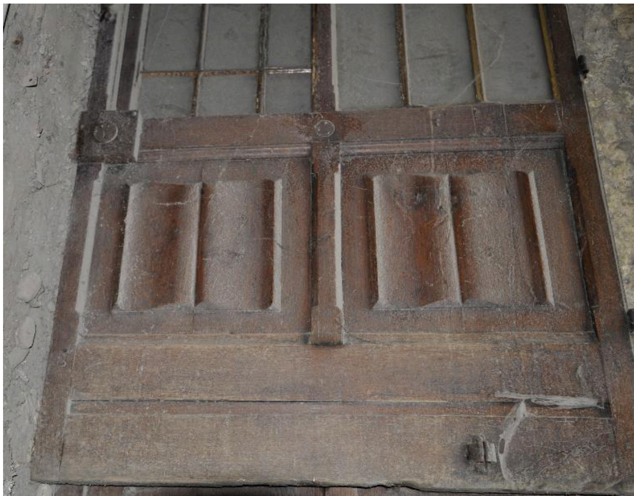
Vantail de la porte de la galerie déposé dans la cave, détail
