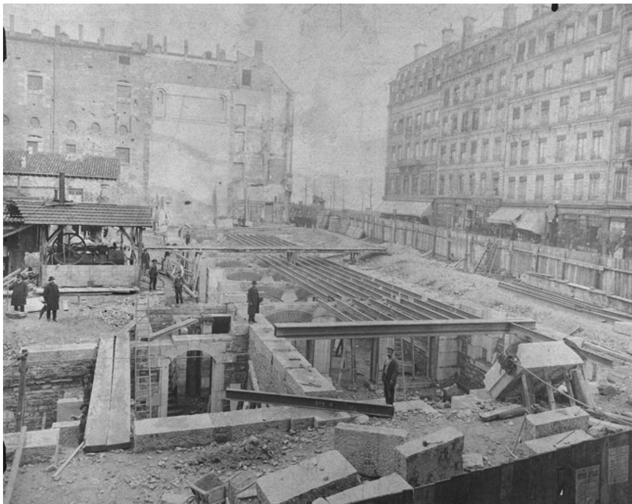
Le bâtiment A' en construction, côté rue de la Barre. Photogr., [4e quart XIXe s.] (A. Musée des HCL. AF 37)
