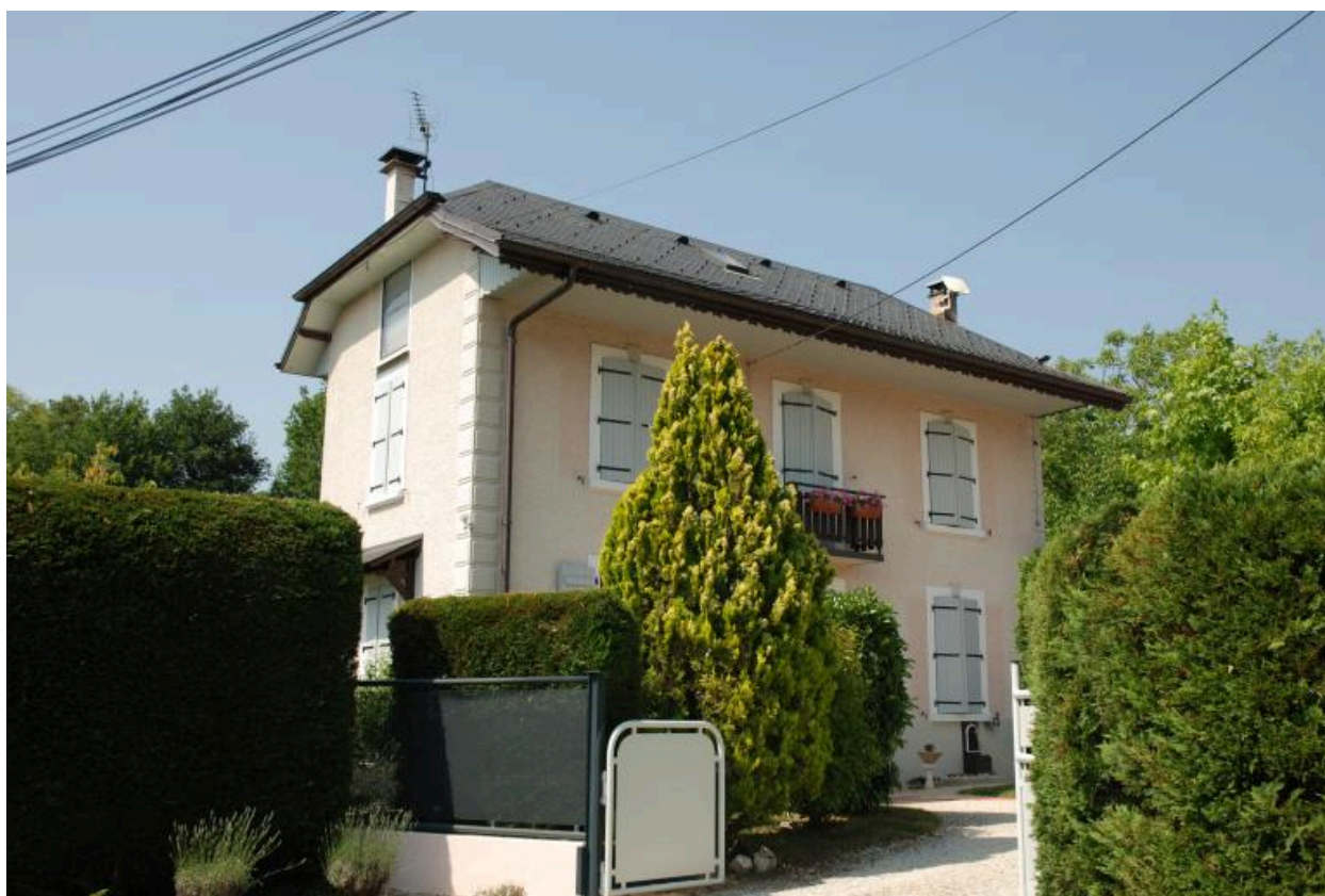
Vue de la maison (2015 B6 449).
