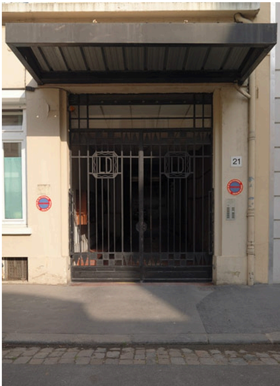
Entrée principale avec auvent et ferronnerie en décor L D : Ligne Droite
